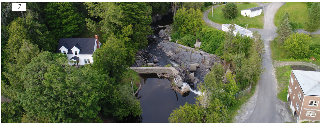
Vue sur les vestiges du barrage de béton, août 2017.
