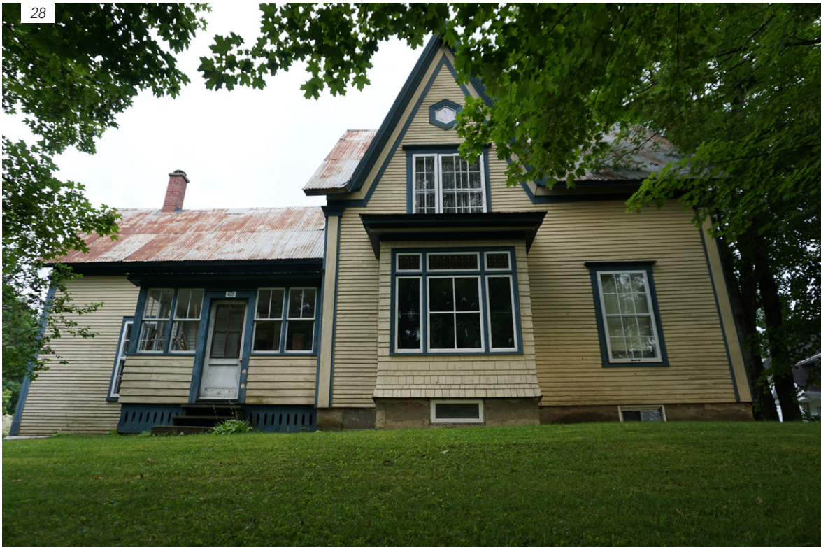
Maison bloc, 422, chemin Chamberlain, août 2017.
