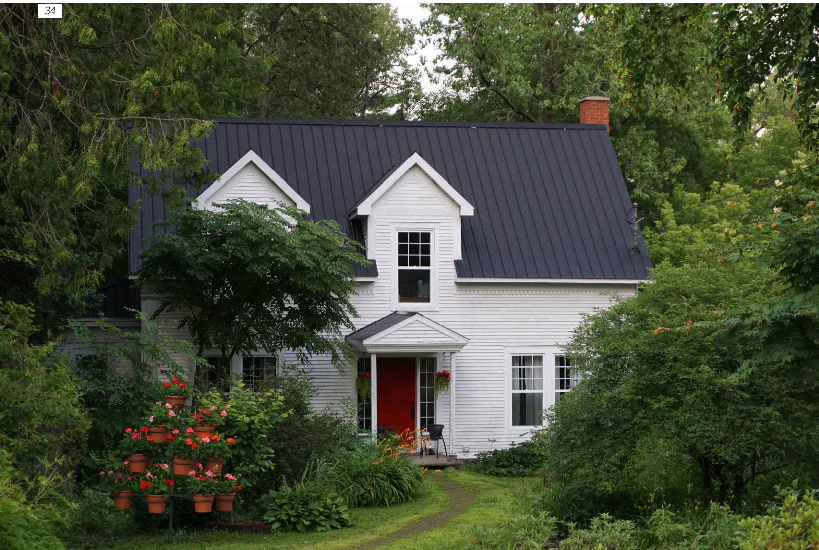
Maison située au 225 chemin Parker, août 2017.
