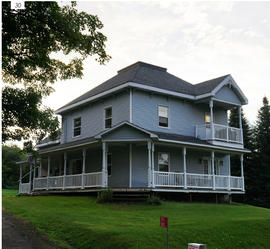
Maison cubique, 381-385 chemin Major, août 2017.
